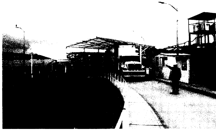
SE APRECIA VISTA PANORAMICA DELANTERA DE LA ESTRUCTURA CONTRUIDA SEGUN SE INDICA EN LOS PLANOS Y DE ACUERDO A LAS ESPECIFICACIONES TECNICAS
