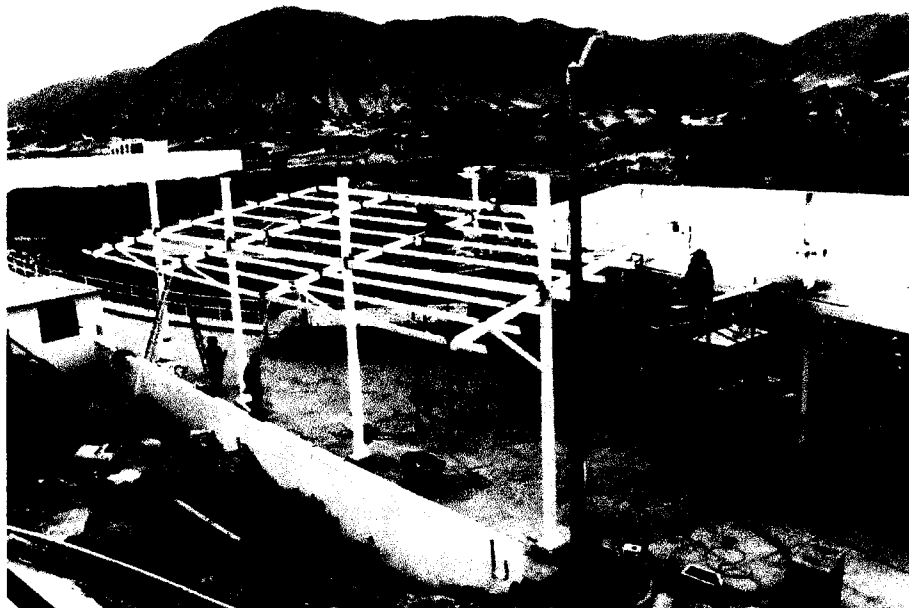
SE APRECIA ESTRUCTURA METALICA COMPLETA
