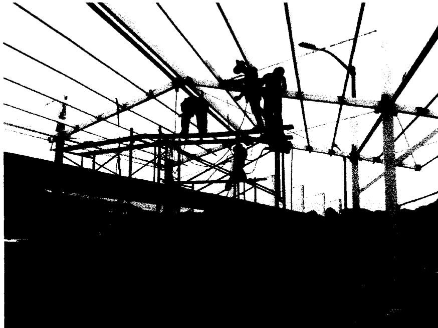
INSTALACION DE TEMPLADORES Y TENSORES DE LA ESTRUCTURA METALICA
