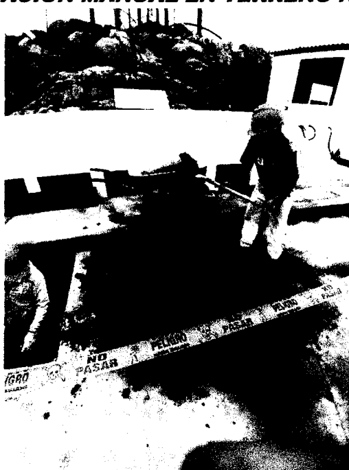
EXCAVACION MANUAL EN TERRENO NORMAL
