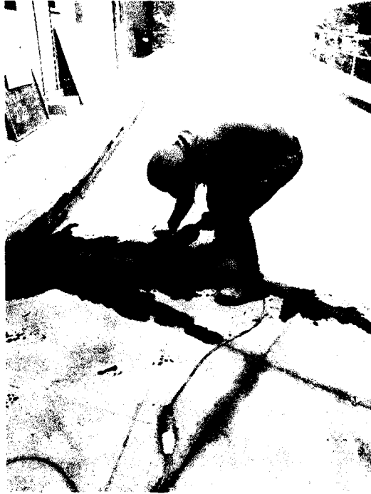
CORTE Y DEMOLICION DE LOSA DE CONCRETO P/CIMENTACION
