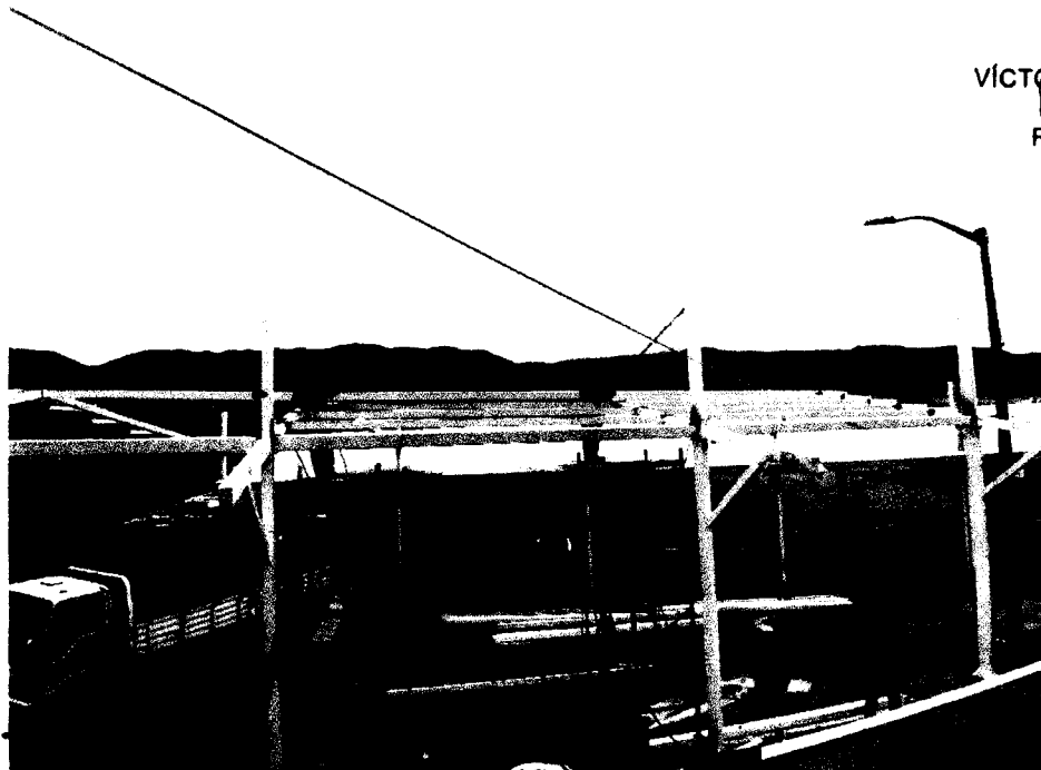
SOLDADURA DE LAS CORREAS DE LA ESTRUCTURA METALICA
